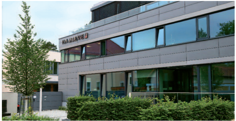
Vertriebszentrale der VON ARDENNE GmbH, Neubau auf der Zeppelinstraße
